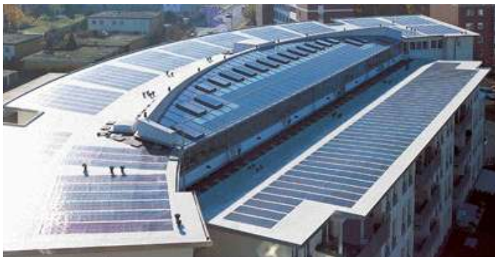
Abb.38 Solarsystem auf Wohnhaus
